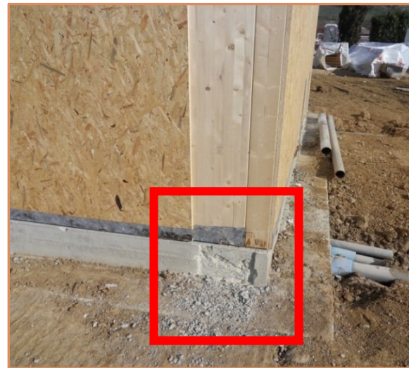
Rimozione del calcestruzzo per il disallineamento orizzontale
