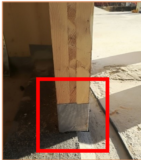
Disallineamenti orizzontali
