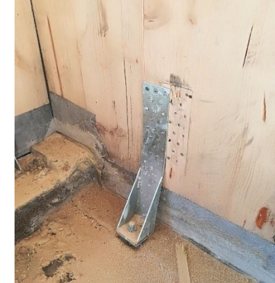
Reinstallando le connessioni
